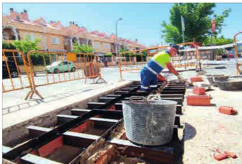
ARCHIVO. Un operario de Aqualia realiza trabajos de arreglo y mejora en imbornales en Jaén capital.
