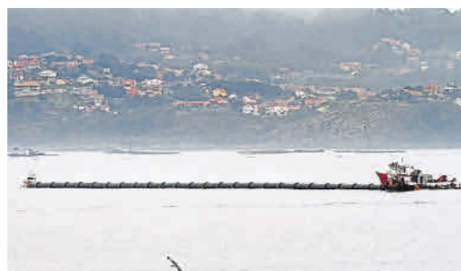
Trabajo de reparación de las uniones entre tramos de hace una década.
